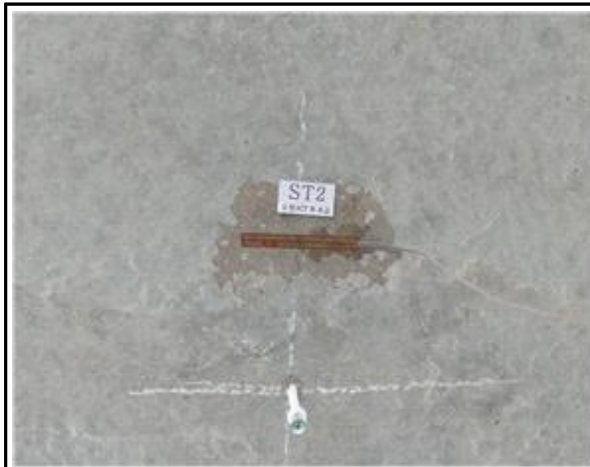
변형률계 설치 현황
