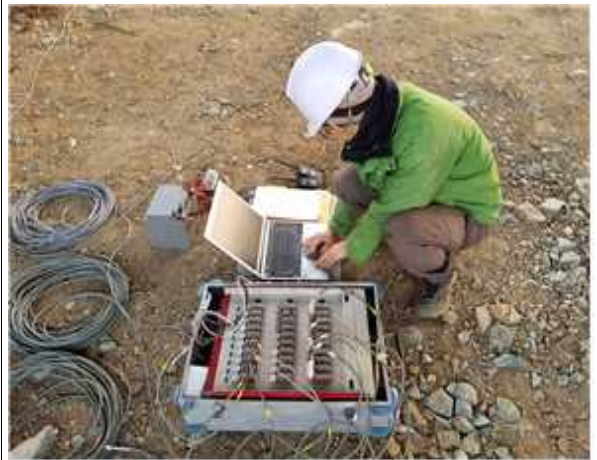
재하시험 계측 전경
