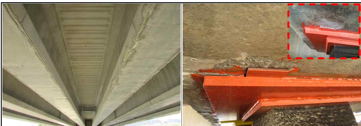
상부 거더 전경
